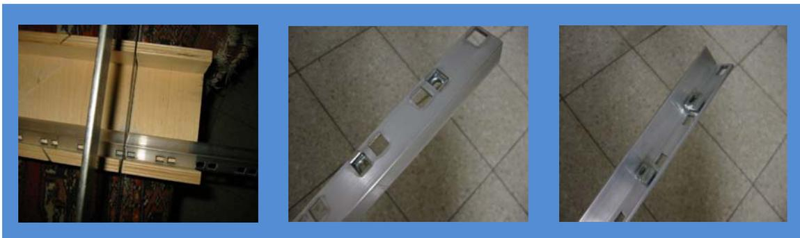
Para unir los perfiles a nuestro rack utilizaremos tornillos de paso M5 (5mm) con tuerca:
